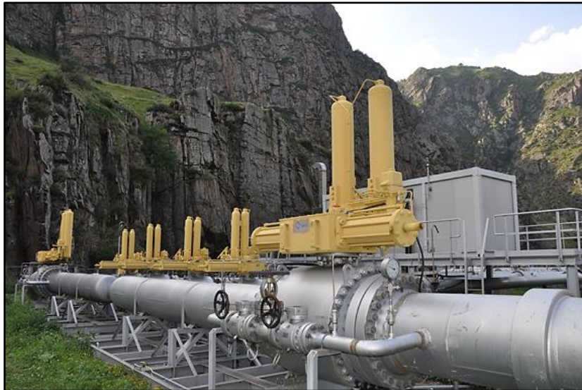
გველეთის გამზომი სადგური ჩრდილოეთ-სამხრეთ კავკასიის მაგისტრალურ მილსადენზე
