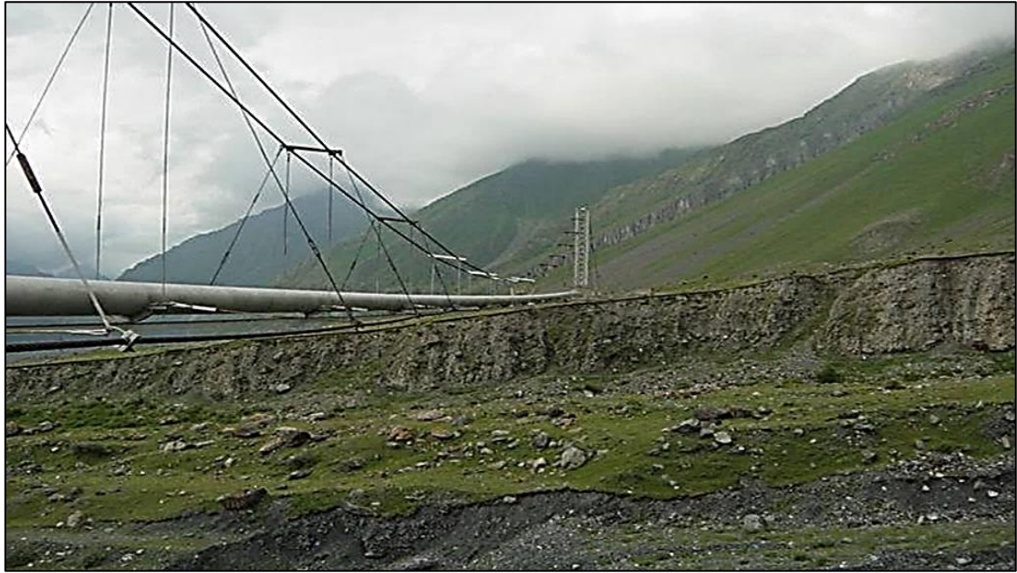
ჩრდილოეთ-სამხრეთ კავკასიის მაგისტრალური გაზსადენის საჰაერო ვანტური გადასასვლელი მდინარე ყუროზე
