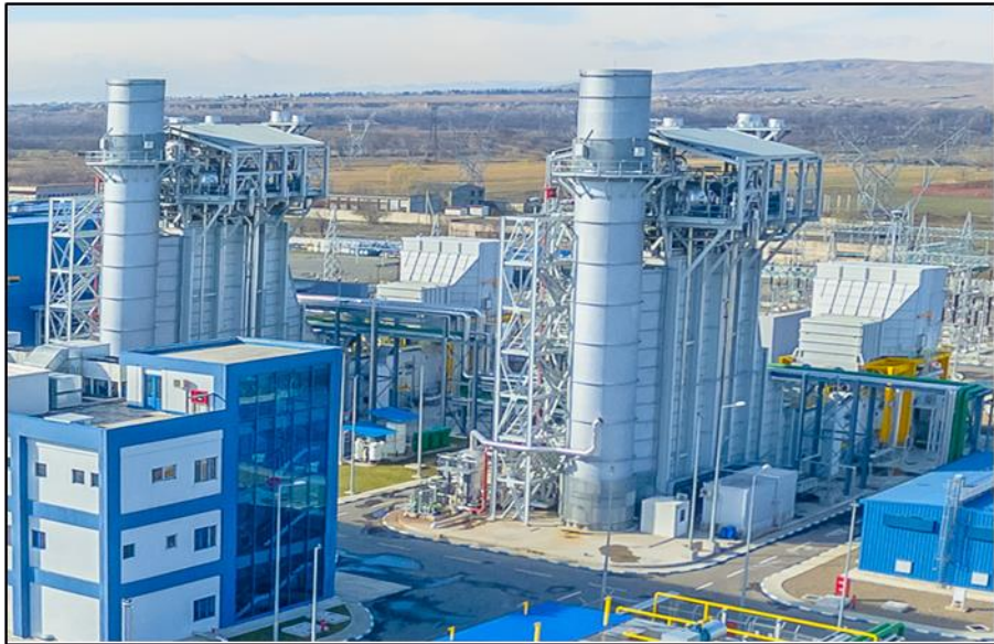
გარდაბნის კომბინირებული ციკლის გაზის თბოელექტროსადგურის ქვაბ-უტილიზატორები
