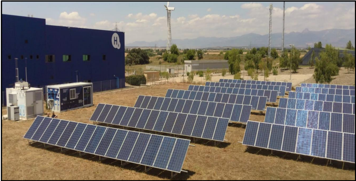
განახლებადი ენერჯით გენერირებული ელექტროდენით წყალბადის წარმოებისა და შენახვის ინდუსტრიული დანადგარი (მწარმოებლობა 1 კგH 2 /სთ) 417
