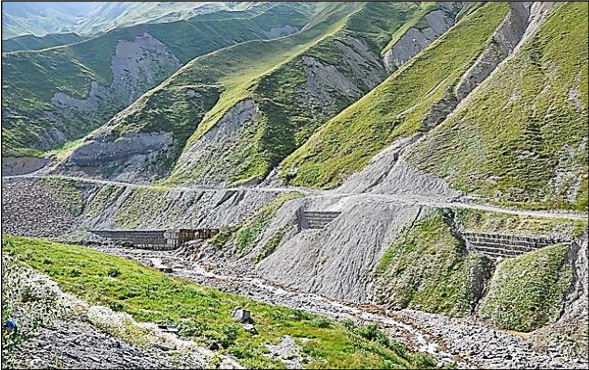
ნაპირდაცვითი ნაგებობები ჩრდილოეთ-სამხრეთ კავკასიის მაგისტრალურ გაზსადენზე
