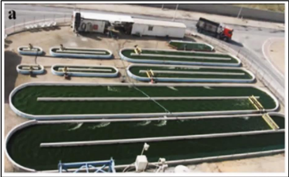
ღარისებური გუბურა წყალბადის გამომმუშავებელი წყალმცენარეების ზრდა-გამრავლებისათვის
