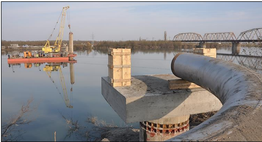
მდინარე რიონის საჰაერო გადასასვლელის მშენებლობა მცურავი საშუალებების გამოყენებით
