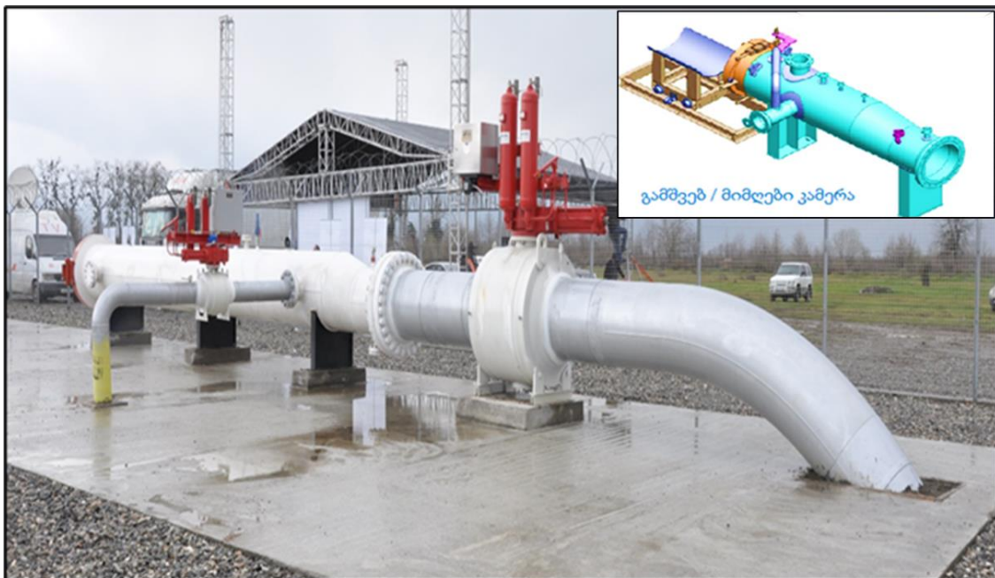
გამშვები კვანძი „აბაშა-სენაკის“ მაგისტრალურ გაზსადენზე
