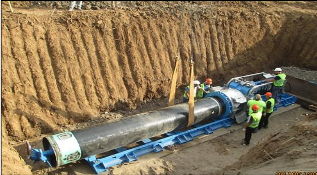
ავტოსატრანსპორტო მაგისტრალის კვეთა საბურღი დანადგარის გამოყენებით
