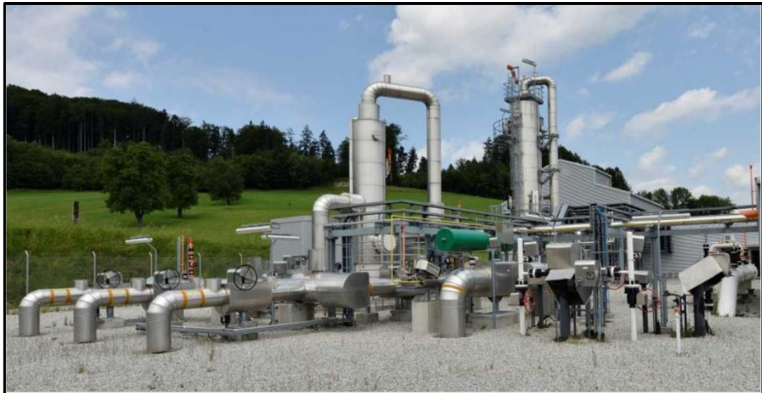
ნახშირორჟანგის დასაწყობების მიწისქვეშა გაზსაცავის ზედაპირული კომპლექსი 481
